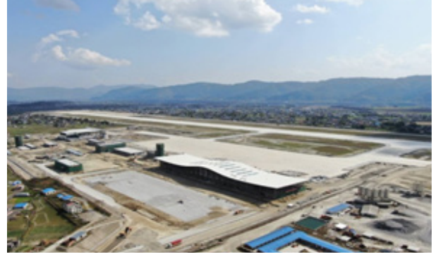
निर्माणाधिन पोखरा अन्तर्राष्ट्रिय विमानस्थल
